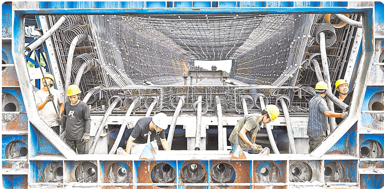
◀ 2025年9月10日,位于铜梁区庆隆镇的中铁四局成渝中线重庆段站前2标钢梁制梁场,工人正在安装箱梁的端模
