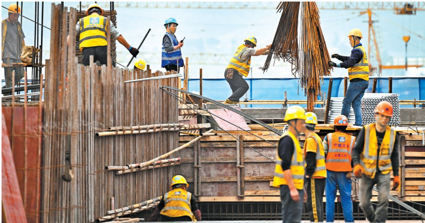
▲2025年4月4日,位于礼嘉智慧公园西区的礼嘉创新中心施工现场,300余名技术工人正抓紧施工,加快推进项目建设(资料图)
