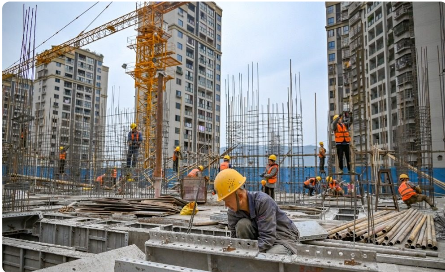
2025年3月11日,万州区钟鼓楼街道,上百名工人正加紧黄泥包还房建设
